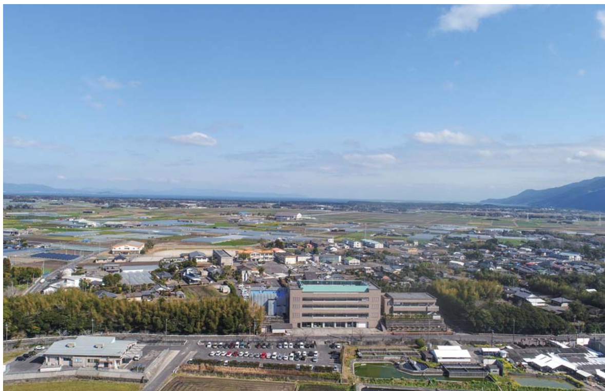
上空からみた東串良町役場周辺
