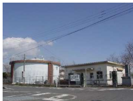
第1水源及び雪山配水池
